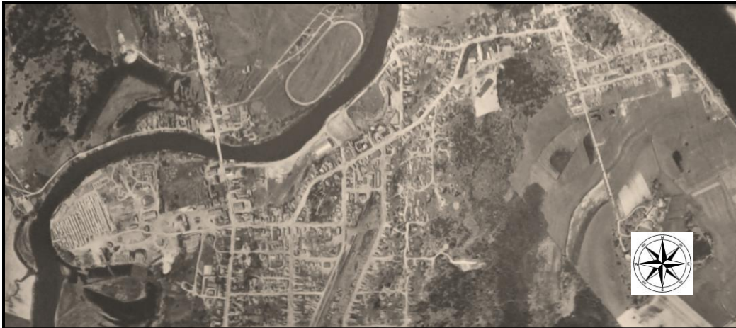
Figure 2.3 : Vue aérienne de la ville de Maniwaki en 1951
