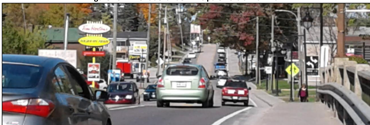
Figure 10.1 : Pont de la rue Principale nord à Maniwaki
