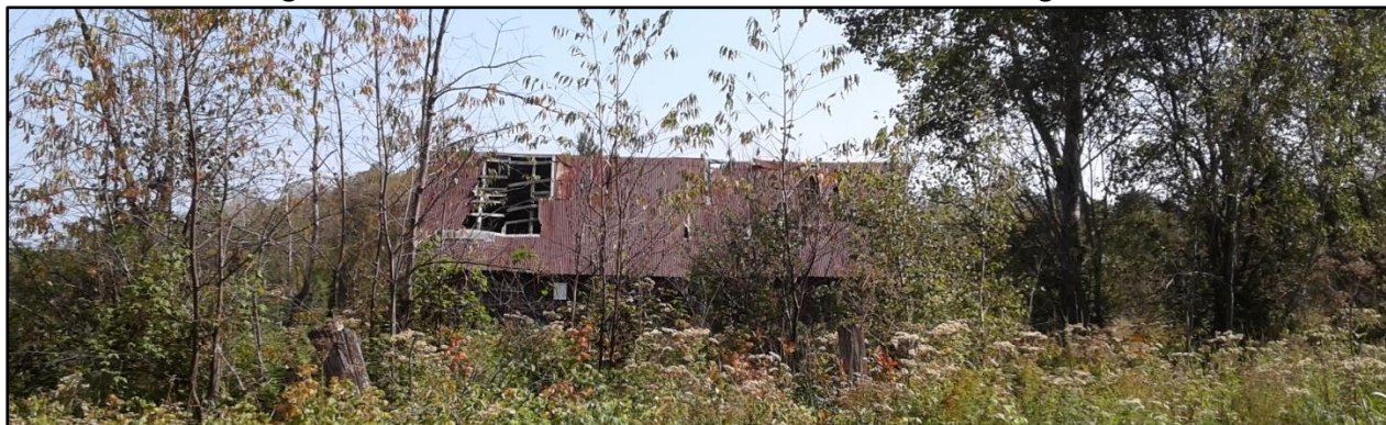
Figure 6.12 : Bâtiment de ferme abandonné dans la zone agricole
