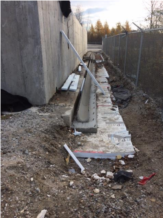
Photos 3 – Ouvrage de captation des eaux de ruissellement (en construction)
