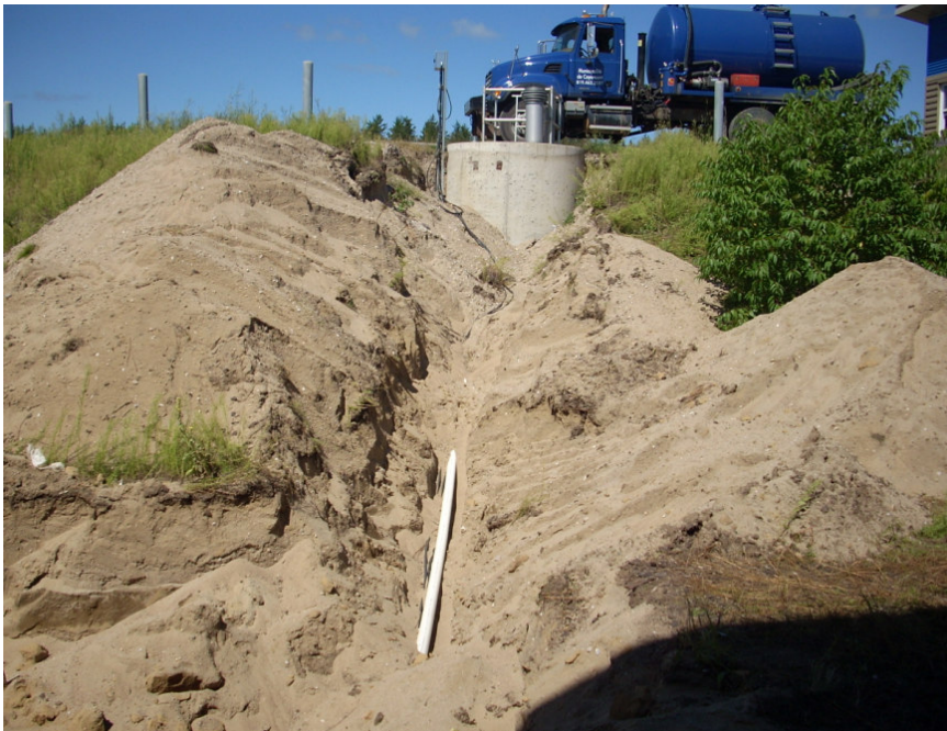
Figure D – Excavation lors du blocage de la conduite d'amenée
