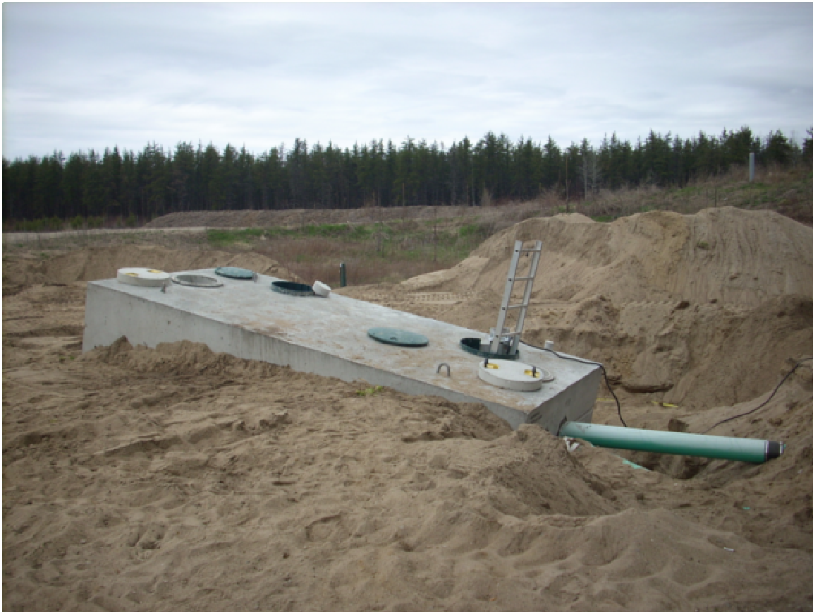
Installation du bassin de captation des mousses et des solides
