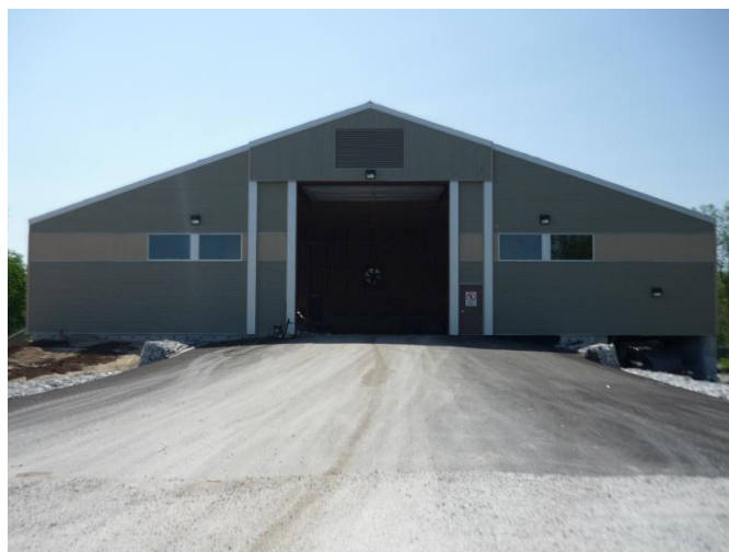
Figure 7 - Bâtiment de transfert
