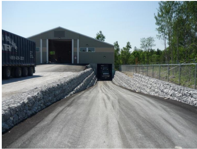
Figure 8 - Vue des deux étages du bâtiment de transfert
